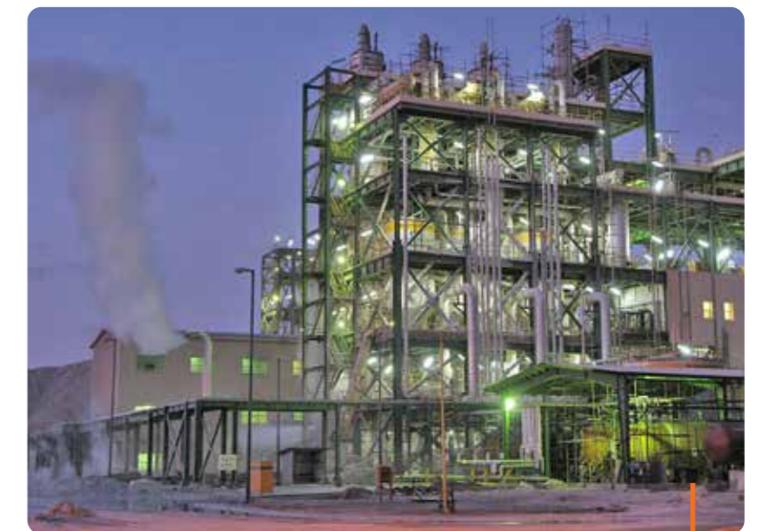
عملیات اجرایی و نصب کارخانه کربنات سدیم سرخه سمنان محل: سمنان
