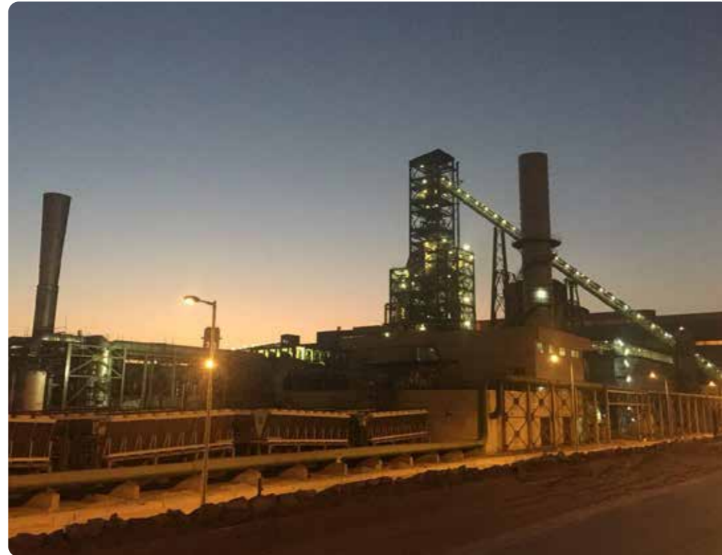
اجرای عملیات ساختمانی و نصب و راه‌اندازی واحد مگامدول احیا مستقیم محل: اردکان، یزد
