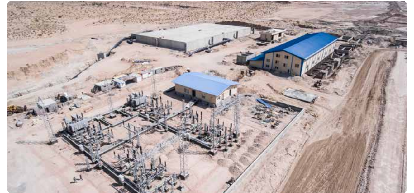
پروژه خط انتقال آب ۱۶۰۰ میلی‌متر از خلیج فارس به صنایع جنوب شرق کشور به طول ۳۰۰ کیلومتر و ۷ ایستگاه تلمبه‌خانه محل: بندرعباس
