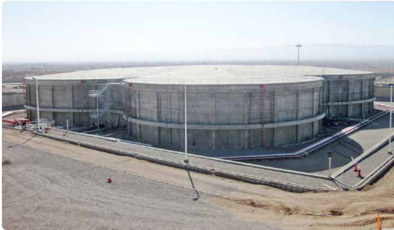
پروژه احداث مخزن ۶۰,۰۰۰ هزار مترمکعبی گازوئیل به صورت نیمه‌مدفون در نیروگاه سیکل ترکیبی کرمان محل: کرمان
