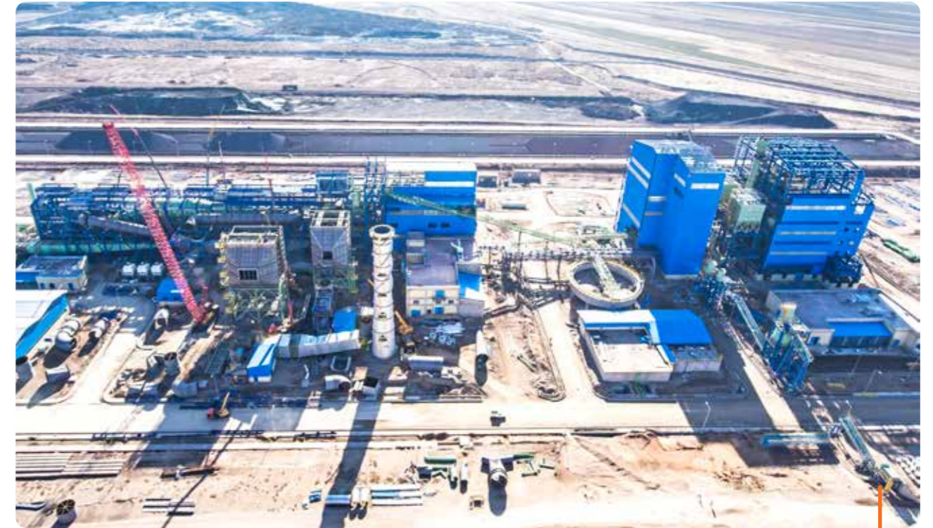
پروژه احداث کارخانه گندله‌سازی به ظرفیت ۲/۵ میلیون تن در سال محل: نیشابور
