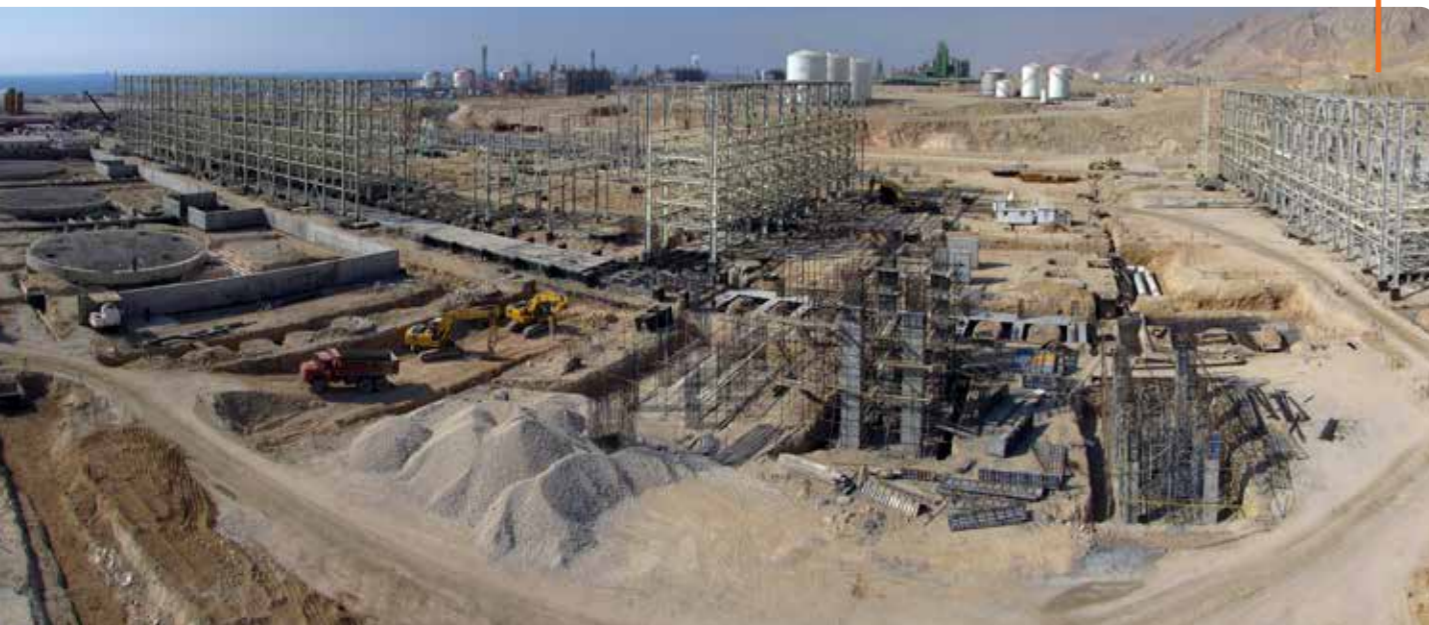
پروژه ساخت ساختمان صنعتی و نصب خط لوله زیرزمینی متانول پتروشیمی بوشهر محل: عسلویه
