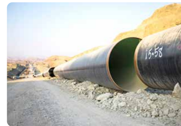
پروژه خط انتقال آب ۱۶۰۰ میلی‌متر از خلیج فارس به صنایع جنوب شرق کشور به طول ۳۰۰ کیلومتر و ۷ ایستگاه تلمبه‌خانه محل: بندرعباس
